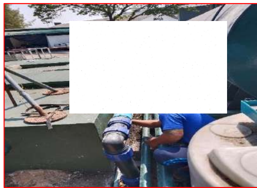
ภาพที่ 5-6 ดำเนินการแก้ไขท่อเมนต้นน้ำเสียก่อนเข้าระบบแตก
