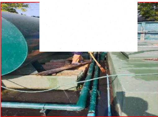
ภาพที่ 5-6 ดำเนินการแก้ไขท่อเมนต้นน้ำเสียก่อนเข้าระบบแตก
