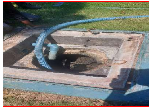
ภาพที่ 1-2 ดำเนินการดูดตะกอนที่สะสมในบ่อ
