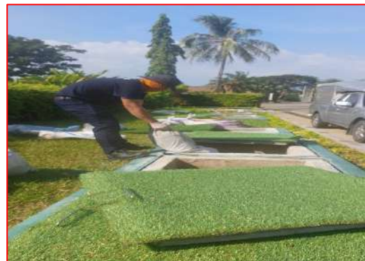
ภาพที่ 7-8 ดำเนินการเติมจุลินทรีย์ในบ่อเติมอากาศ
