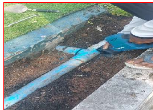
ภาพที่ 3-4 ดำเนินการแก้ไขท่ออากาศที่แตกใหม่
